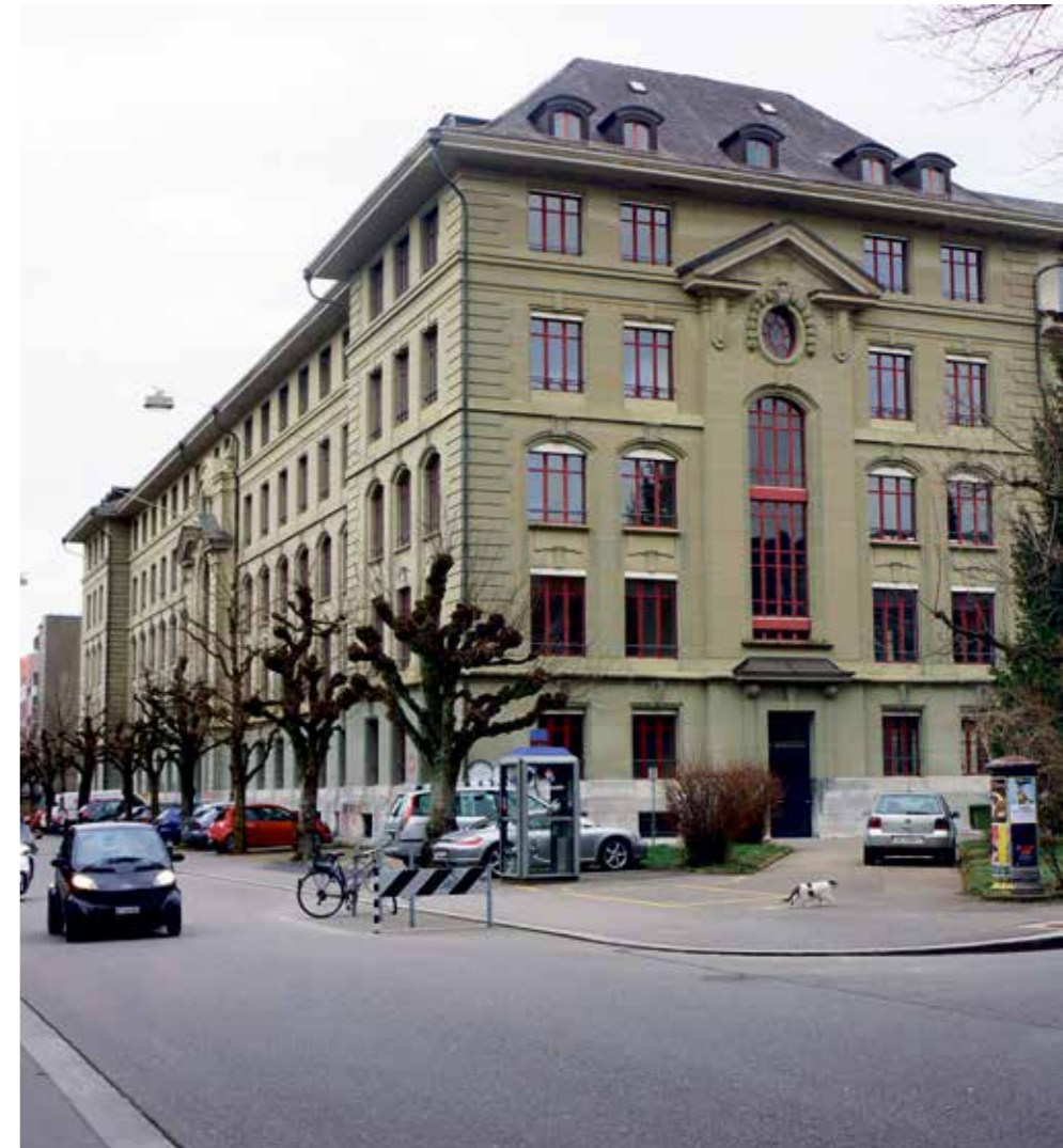
Mittelstrasse 43: Das ehemalige SBB-Gebäude wird bis 2018 mehrere Institute beherbergen.
