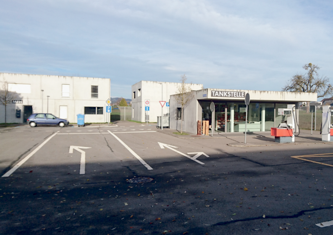
Für das Erproben von Ernstfällen wurde ein winziges Dörfli aufgebaut: zwei Mehrfamilienhäuser, ein Einfamilienhaus, eine Bank, eine Tankstelle.
