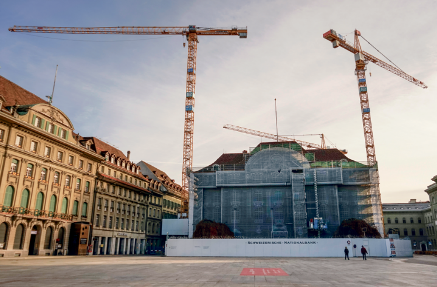
Gelber Kran links: Liebherr 250 ec-b, gehört Wirz, war zuvor an der Kasparstrasse in Bern. Gestellt am 22. Mai 2015, Ausladung: 60 Meter, Traglast: 12 Tonnen, Hakenhöhe: 65 Meter. «Als während der Montage bei der Nationalbank der Geldtransport ankam, mussten alle Arbeiten unterbrochen werden.»
